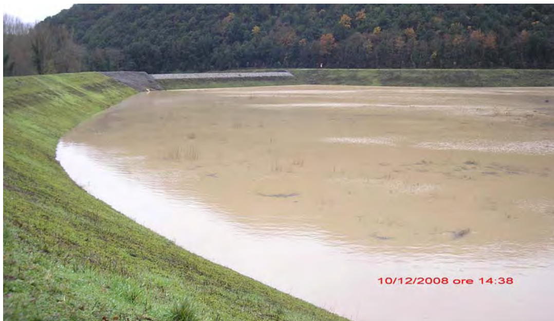
Figura 17b – Cassa d'espansione di Molino dei Bagni (T.Chiani) durante l'evento alluvionale (foto Consorzio di Bonifica Val di Chiana Romana e Val di Paglia)
